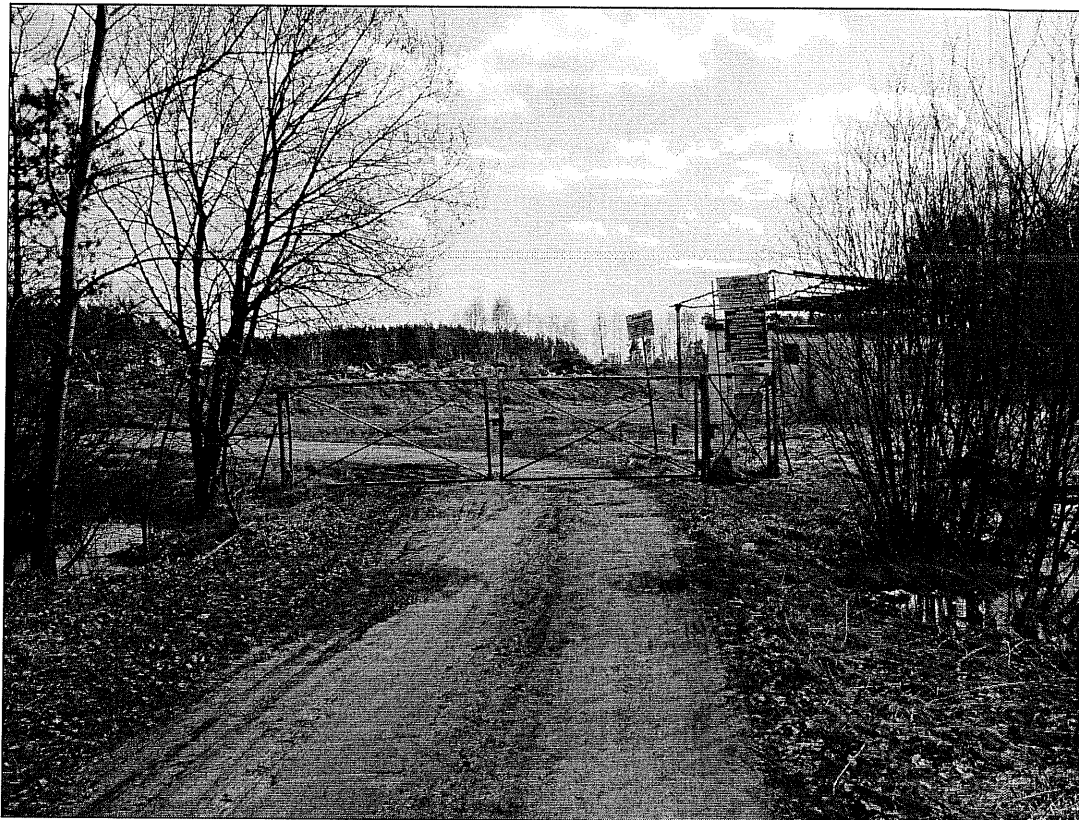
Rysunek 3.4 Składowisko odpadów innych niż niebezpieczne i obojętne w Chocianowie.
