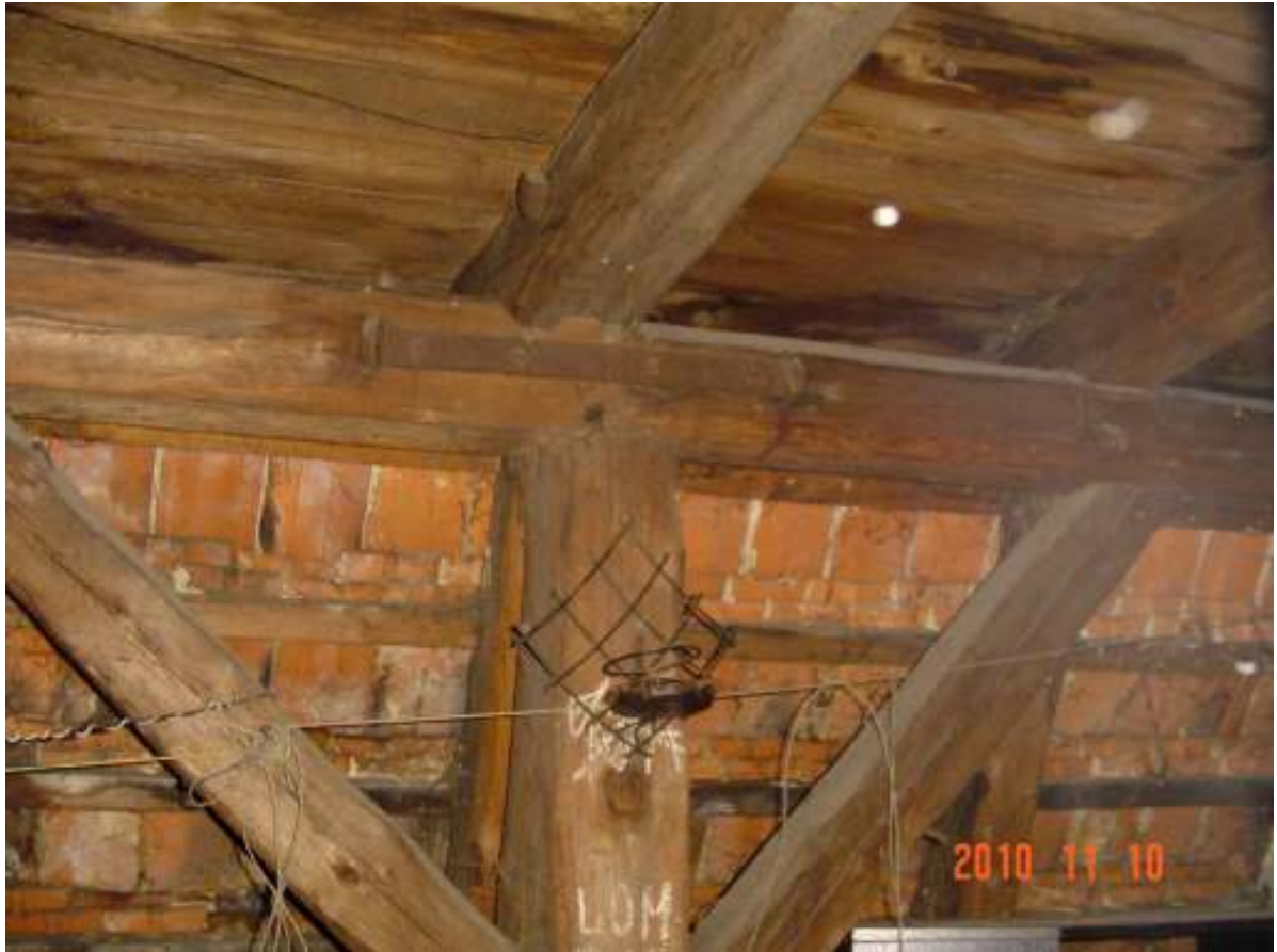
Fot.2 Widoczne zniszczone deskowanie dachu.
