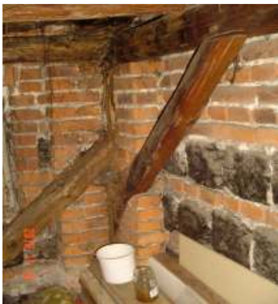
Fot.4 Widoczne zniszczone elementy konstrukcyjne dachu.
