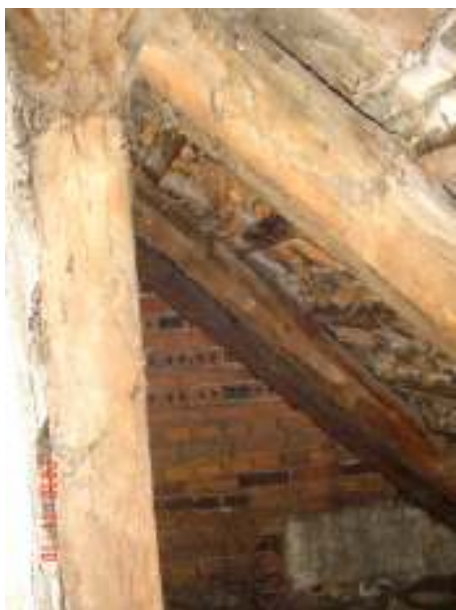
Fot.3 Widoczne zniszczone elementy konstrukcyjne i płatew dachu.
