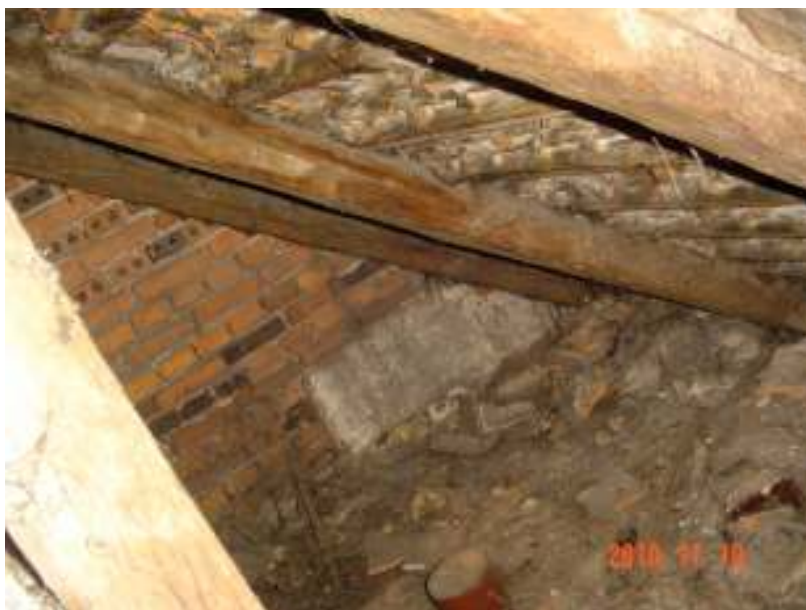
Fot.4 Widoczne zniszczone elementy konstrukcyjne dachu.
