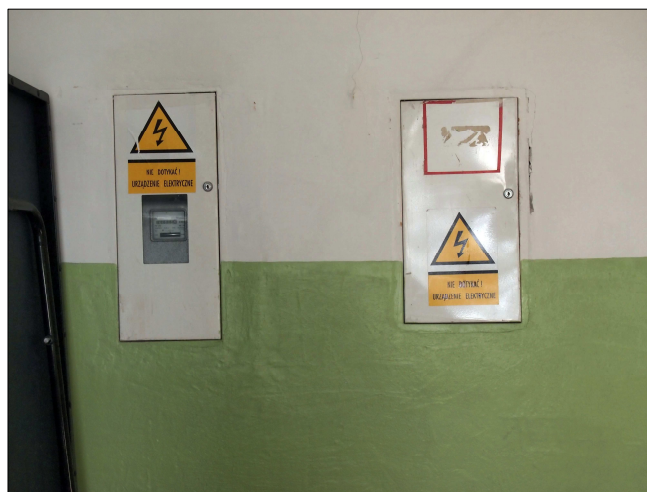
Złącze - skrzynka pomiarowa TL i główna tablica rozdzielcza w budynku
