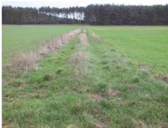
Droga gruntowa w Ogrodzisku
