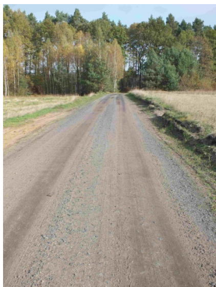
Fot. 38 Droga utwardzona w dobrym stanie w Michałowie
