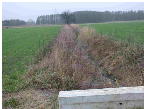
Fot. 46 Rów do modernizacji w Szklarach Dolnych
