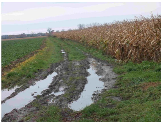
Fot. 37 Droga gruntowa w Żabicach
