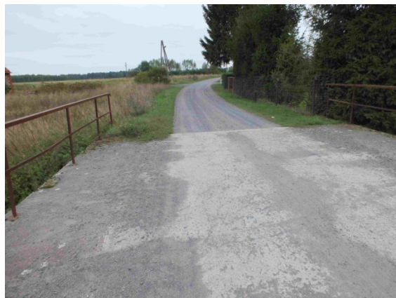
Fot. 33 Droga utwardzona w dobrym stanie w Parchowie
