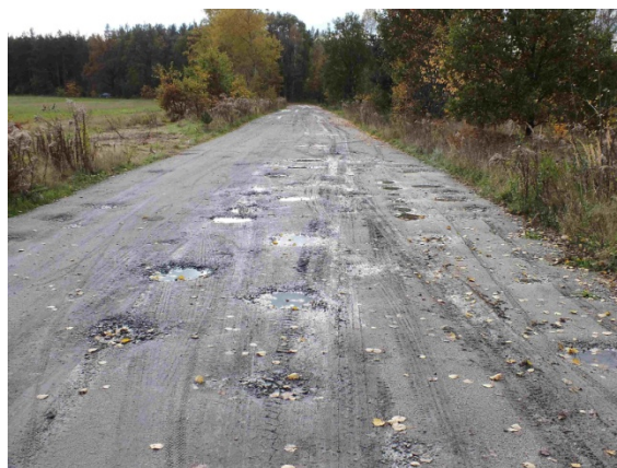
Fot. 48 Droga do przebudowy w Chocianowcu
