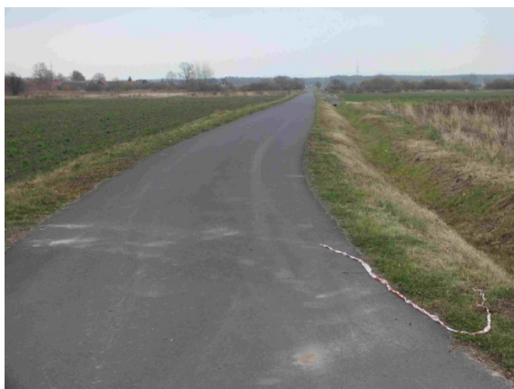
Fot. 32 Droga przebudowana w ramach scalenia gruntów w Szklarach Dolnych
