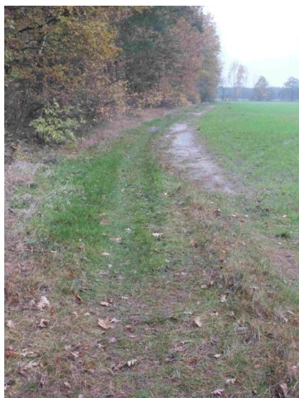
Fot. 39 Droga gruntowa w Parchowie
