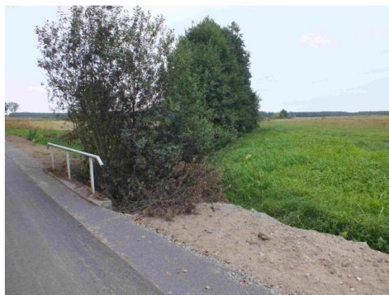
Fot. 26 Rów w złym stanie w Parchowie
