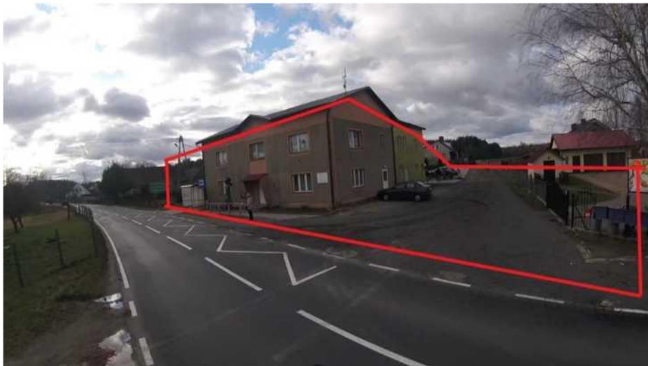
Miejsce montażu urządzenia 2
