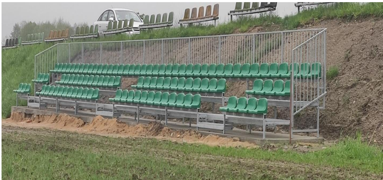
Rysunek 39 Trzebnice – teren boiska sportowego po modernizacji
