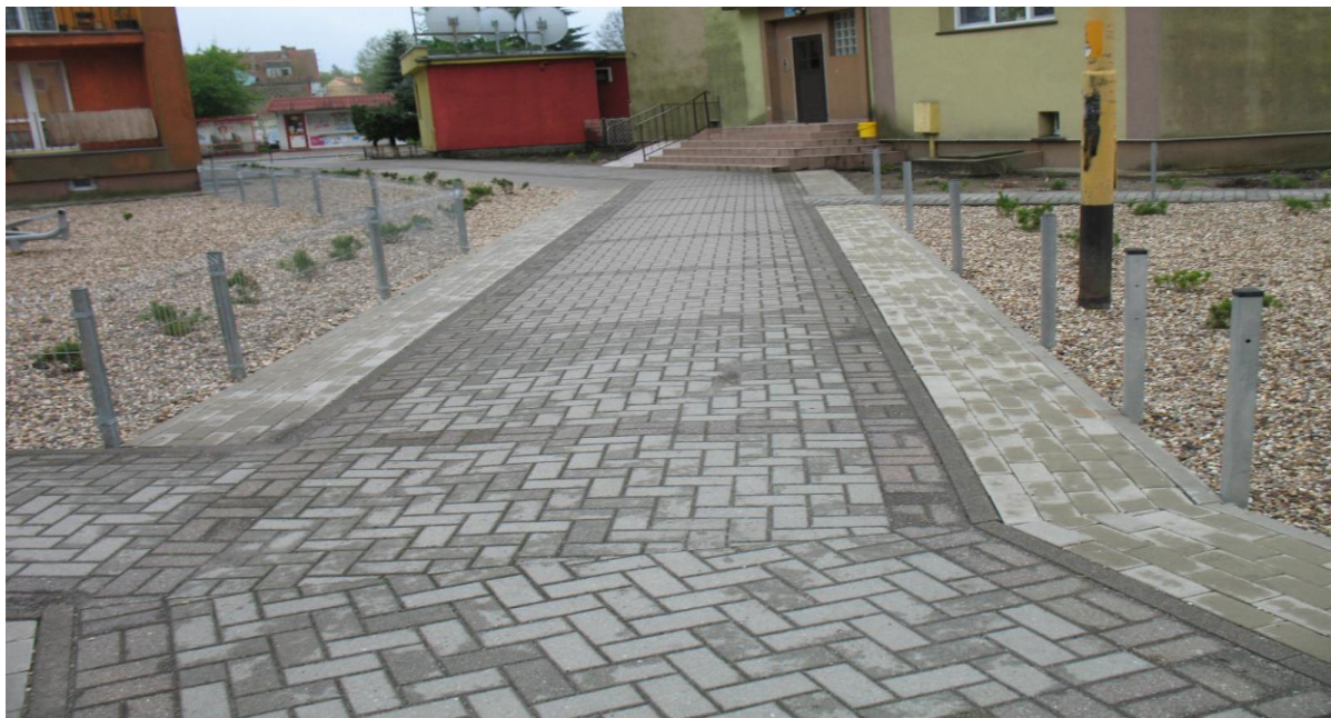
Rysunek 28 Droga pożarowa na ul. Rotmistrza Witolda Pileckiego 16A w Chocianowie
