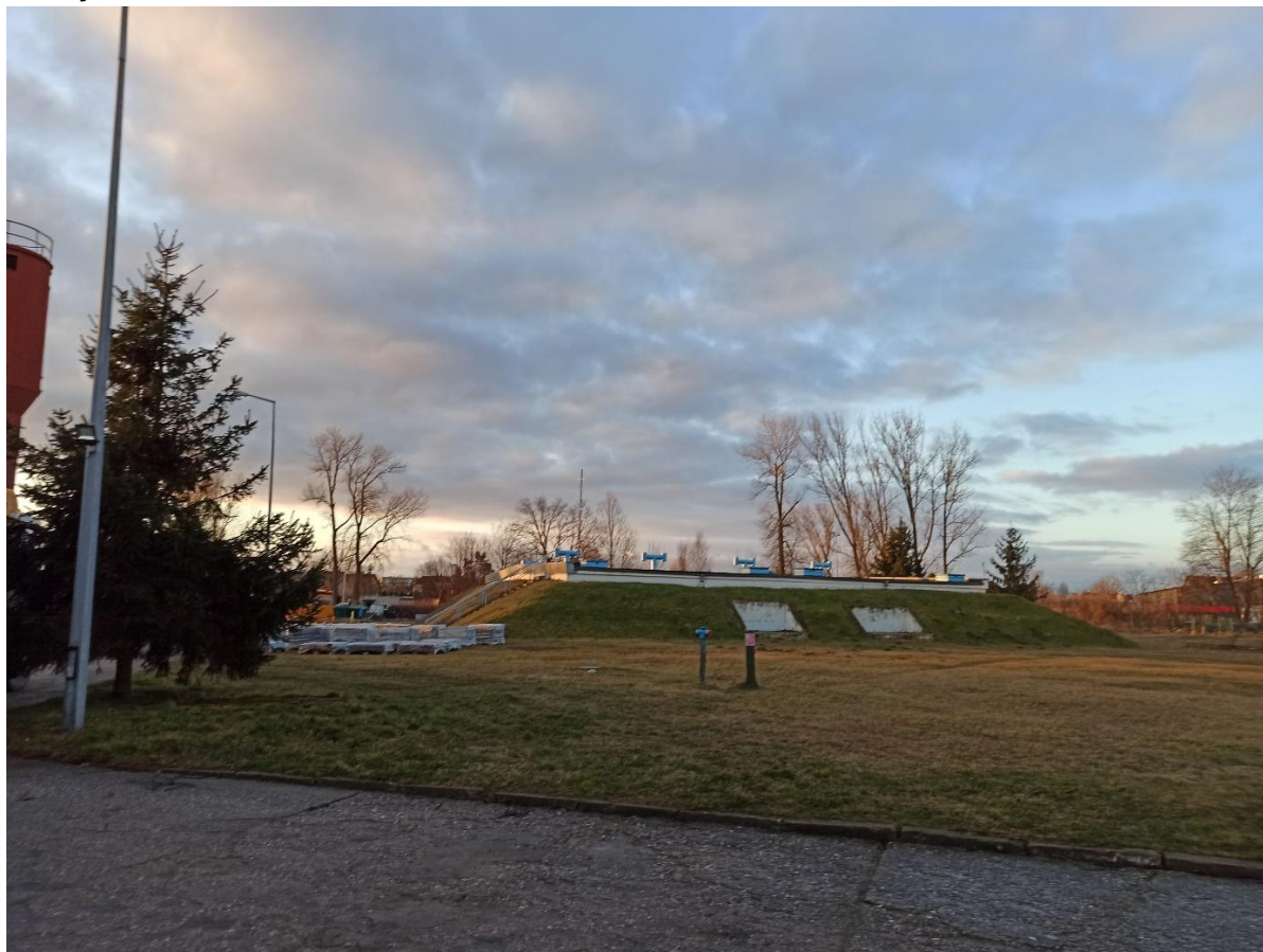
Rysunek 2 Zbiornik magazynujący wodę uzdatnioną na terenie ZUW Chocianów
