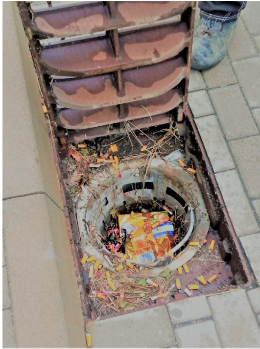
Rysunek 9 Studzienki ściekowe- ujęcie 1
