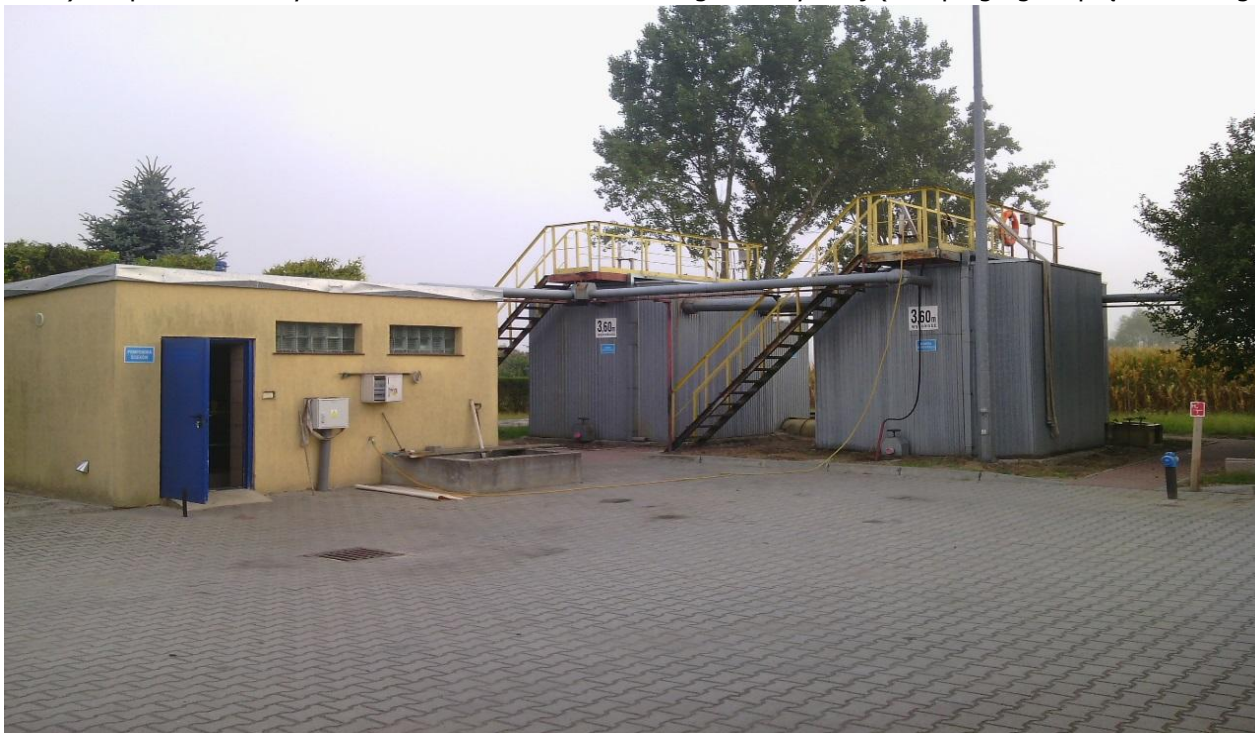
Rysunek 6 Oczyszczalnia ścieków we wsi Trzebnice
