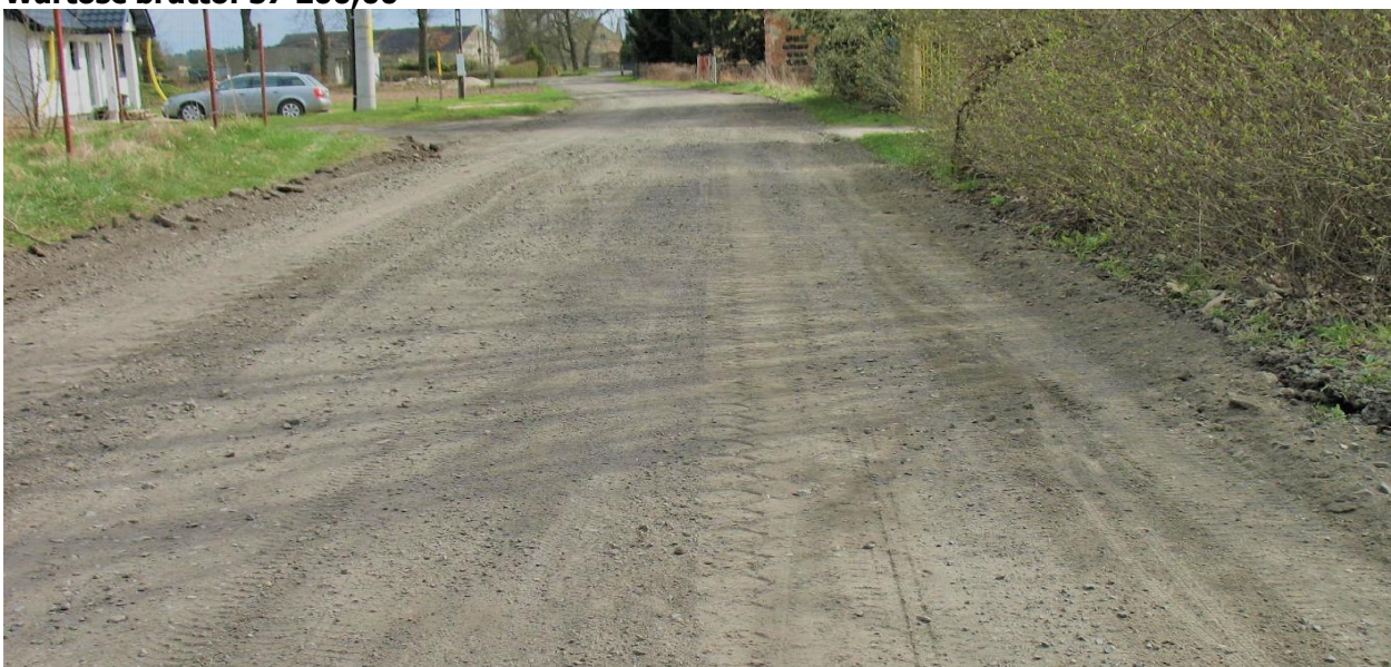
Rysunek 13 Remont/utwardzenie nawierzchni gruntowej
