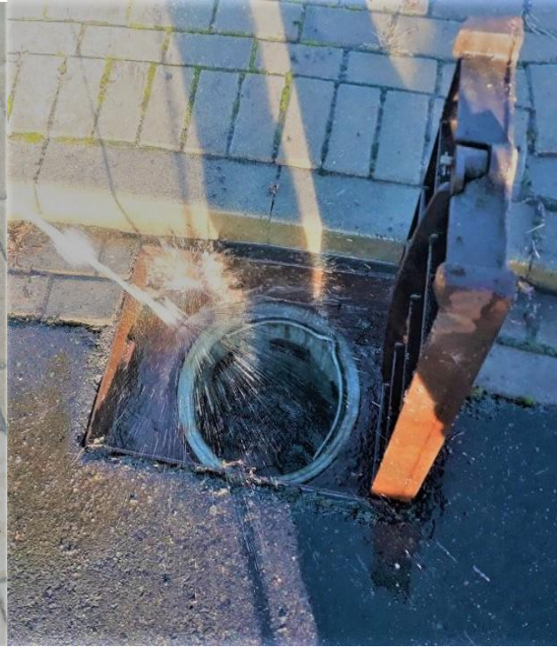
Rysunek 10 Studzienki ściekowe- ujęcie 2
