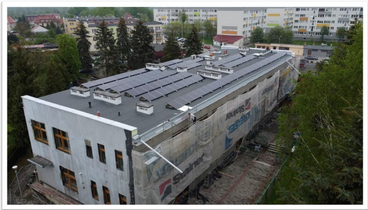
Rysunek 33 Termomodernizacja budynku Szkoły Podstawowej im. Odkrywców Polskiej Miedzi w Chocianowie przy ul. Szkolnej
