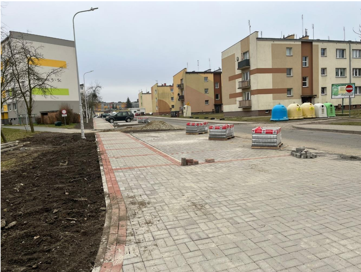
Rysunek 28 Przebudowa ulic: Wesołej i Armii Krajowej w Chocianowie
