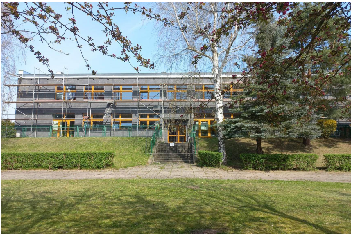
Rysunek 32 Termomodernizacja budynku Przedszkola Miejskiego w Chocianowie przy ul. Wesolej
