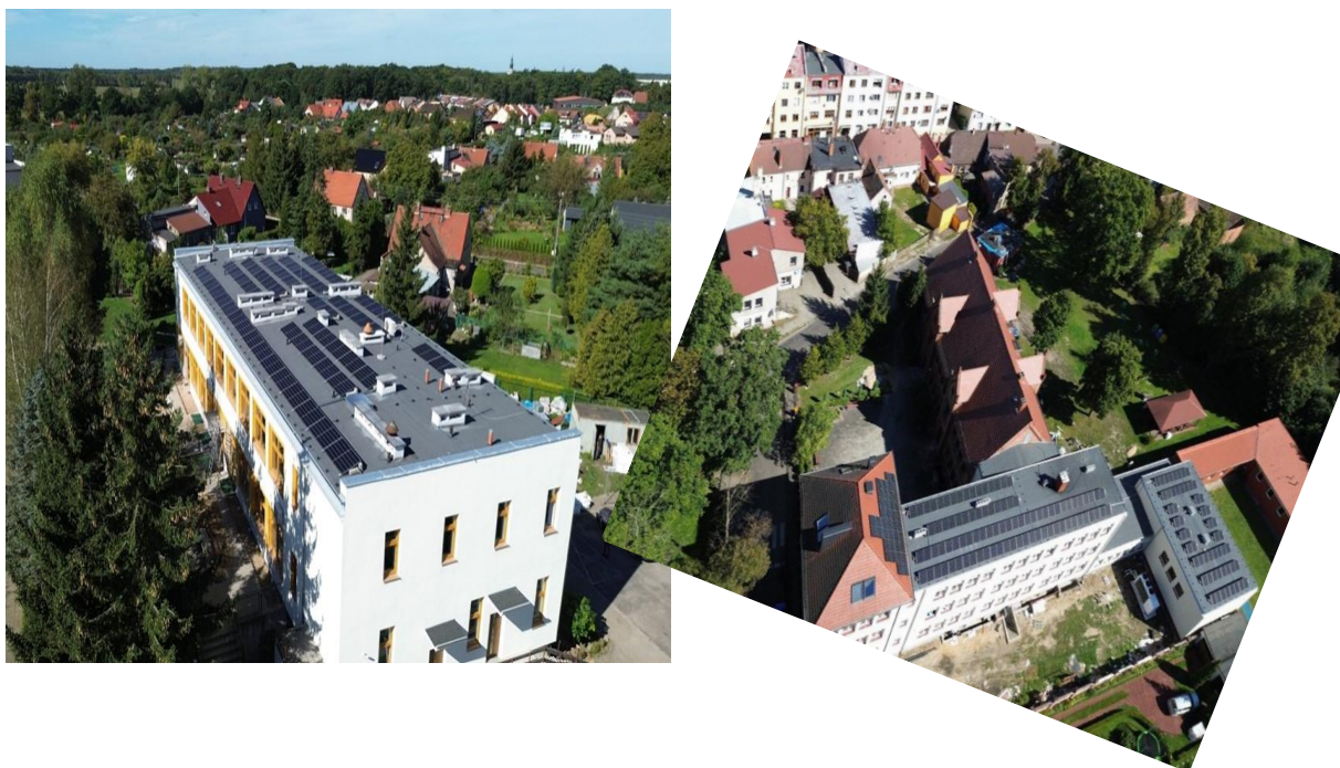
Rysunek 26 Termomodernizacja budynku Szkoły Podstawowej im. Odkrywców Polskiej Miedzi w Chocianowie przy ul. Szkolnej.
