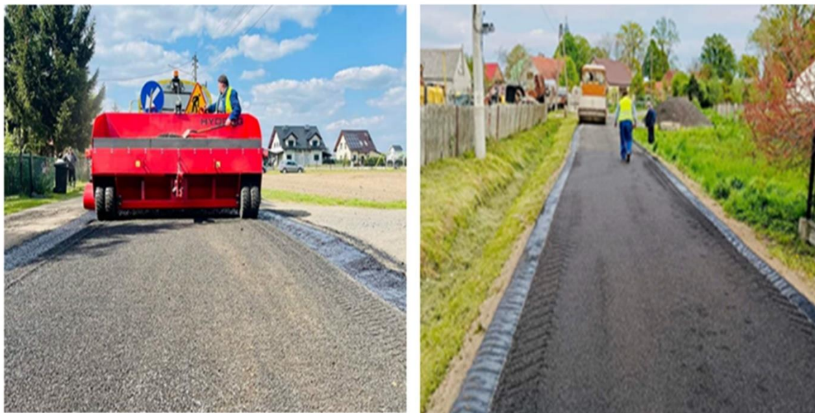
Rysunek 16 Nawierzchniowe utwalenie drogi w Parchowie i Pogorzelskich.
