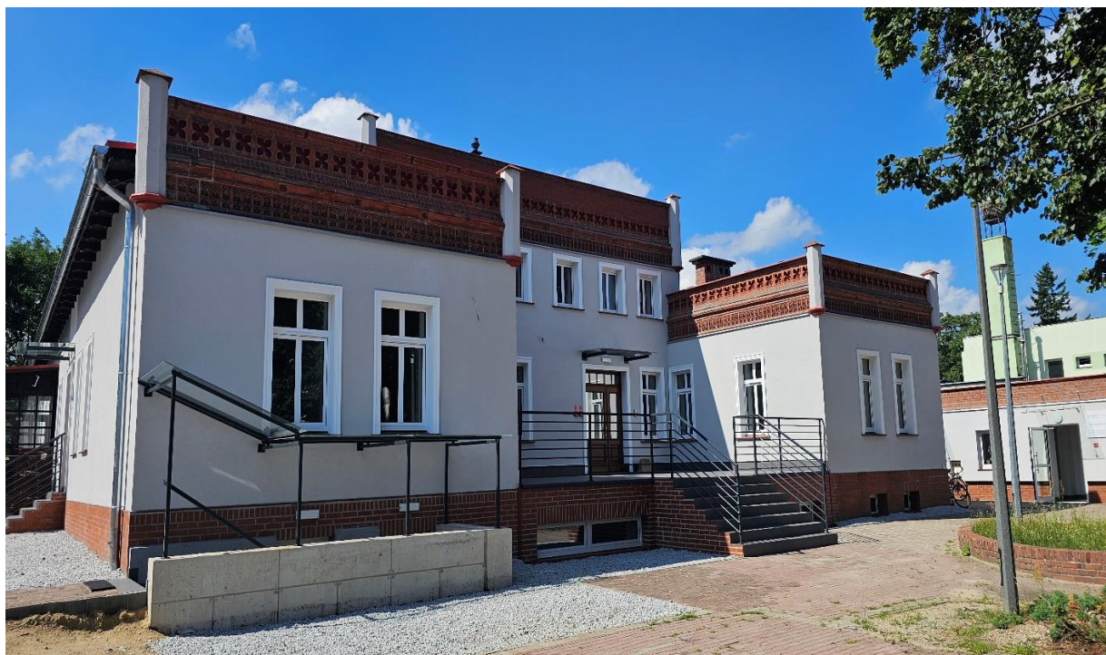
Rysunek 30 Budynek przy ul. 3 Maja 4 w Chocianowie - Centrum Informacji Turystycznej
