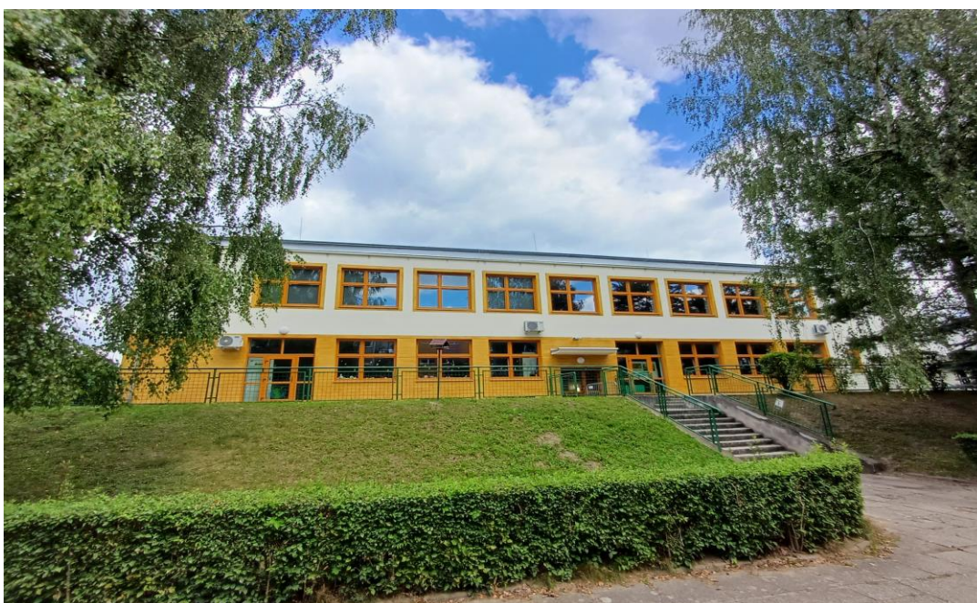
Rysunek 25 Termomodernizacja budynku Przedszkola Miejskiego w Chocianowie przy ul. Wesołej
