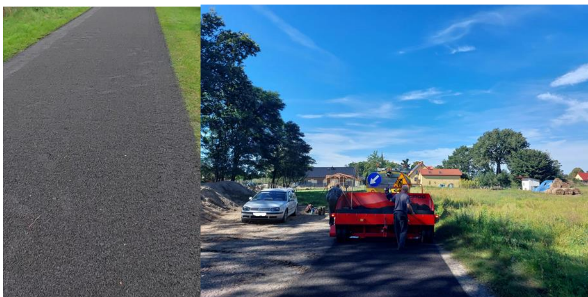
Rysunek 17. Nawierzchniowe utwalenie dróg gruntowych w Żabicach i Brunowie
