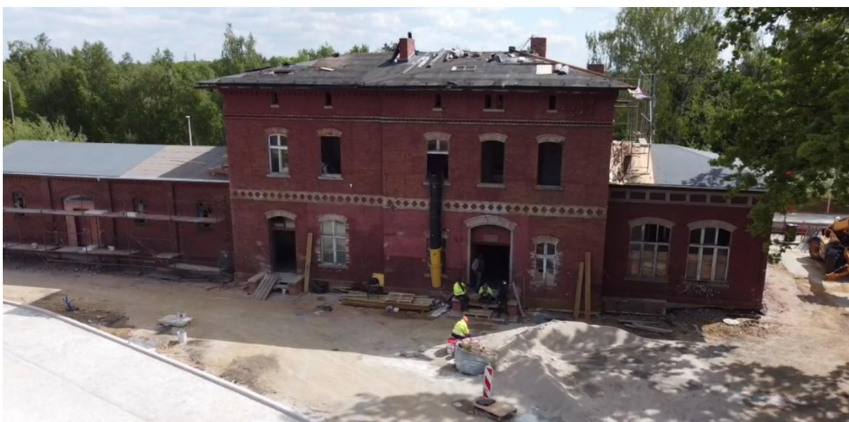
Rysunek 49 Rewitalizacja i modernizacja budynku dworca kolejowego w Chocianowie
