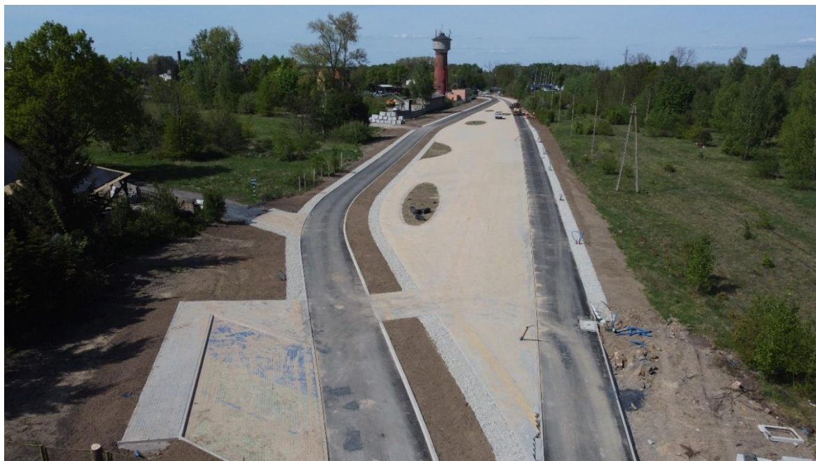
Rysunek 20 Budowa drogi gminnej od ul. Kolejowej do ul. Głogowskiej w Chocianowie
