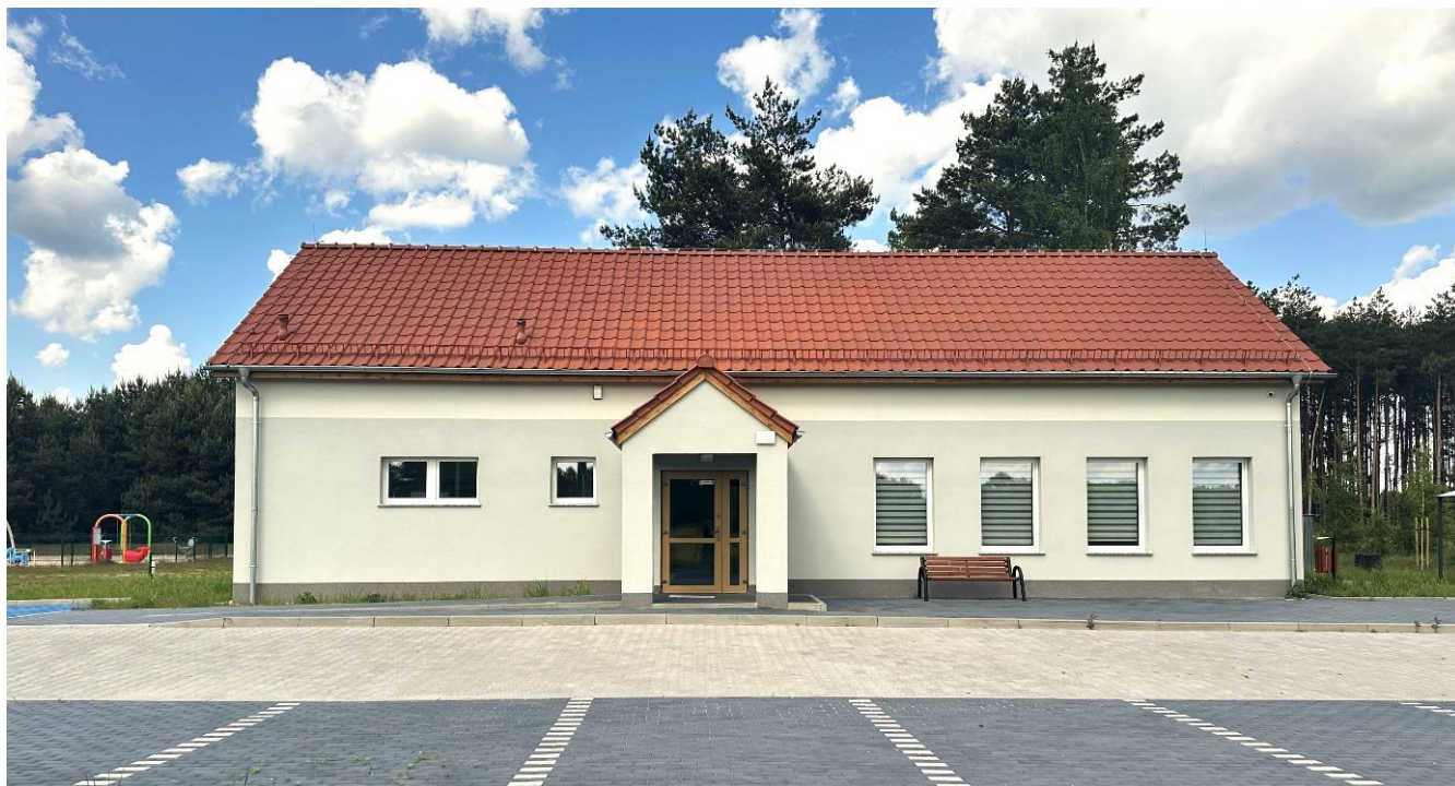
Rysunek 51 Świetlica wiejska w Trzmielowie
