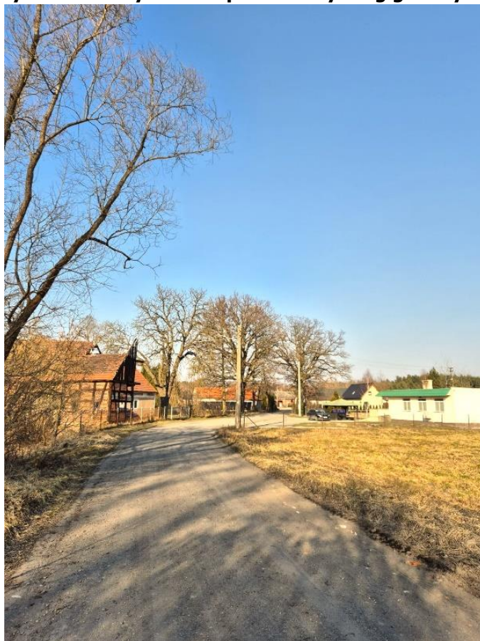
Rysunek 61 Wykonanie podbudowy dróg gminnych
