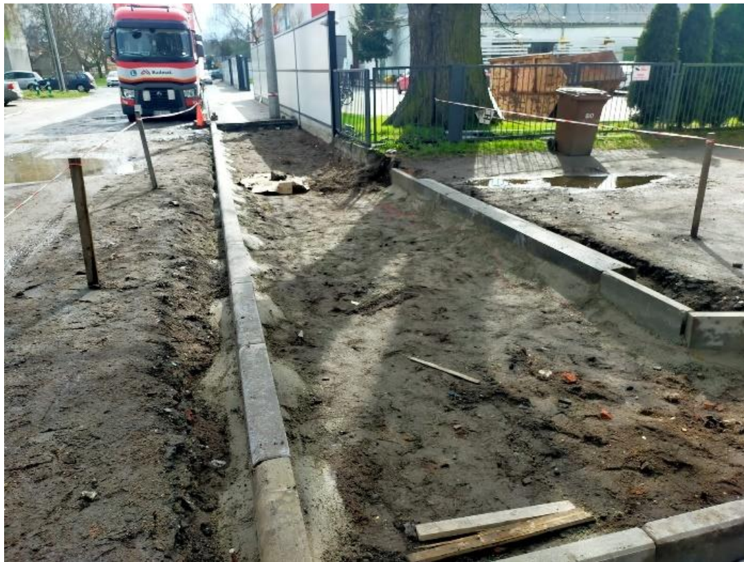
Rysunek 15 Budowa chodnika przy ul. Kolonialnej
