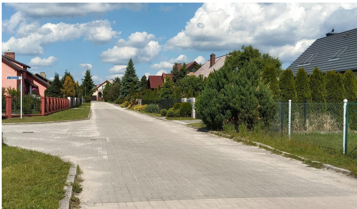
Rysunek 22 Budowa drogi ul. Słoneczna w Chocianowie
