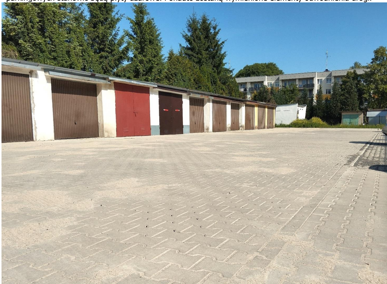
Rysunek 23 Budowa nawierzchni ulicy Sportowej w Chocianowie
