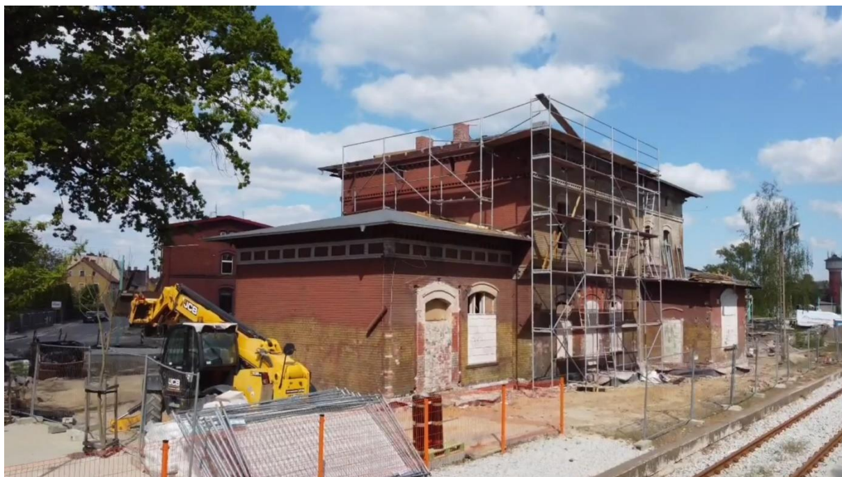
Rysunek 48 Rewitalizacja i modernizacja budynku dworca kolejowego w Chocianowie
