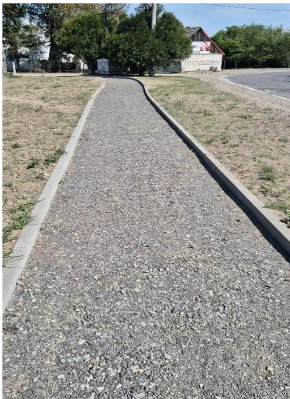
Rysunek 64 Budowa chodnika w miejscowości Parchów
