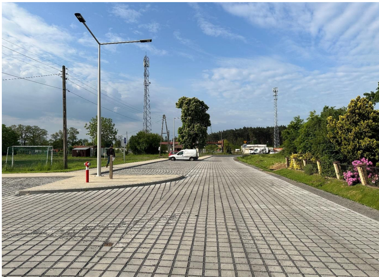
Rysunek 46 Przebudowa nawierzchni drogi gminnej w miejscowości Trzebnice 17.1 Przebudowa ulic: Wesołej i Armii Krajowej w Chocianowie.
