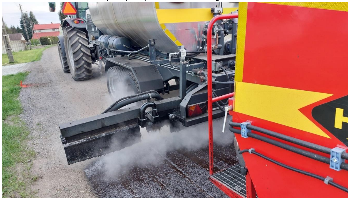
Rysunek 10 Nawierzchniowe utrwalanie drogi gruntowej w Parchowie.
