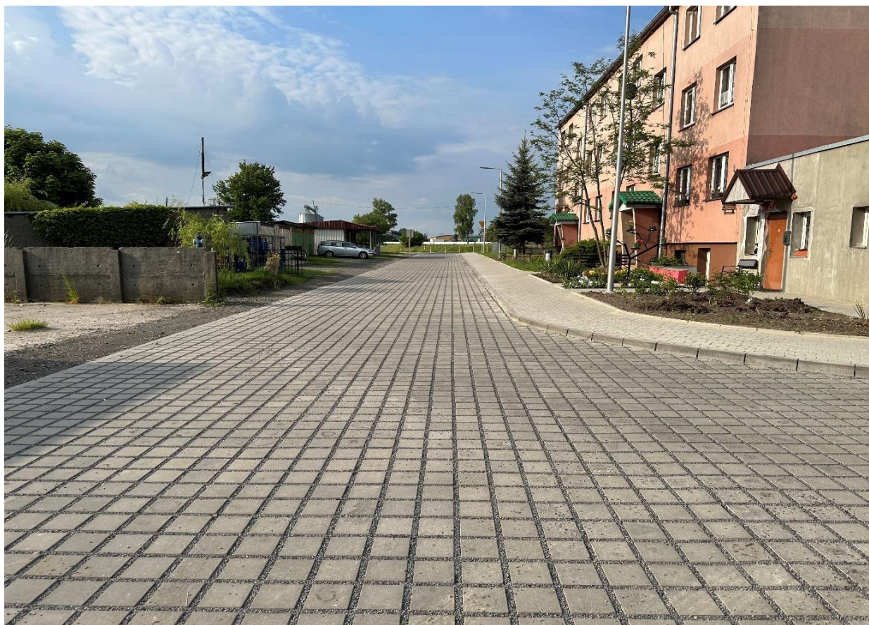
Rysunek 45 Przebudowa nawierzchni drogi gminnej w miejscowości Trzebnice
