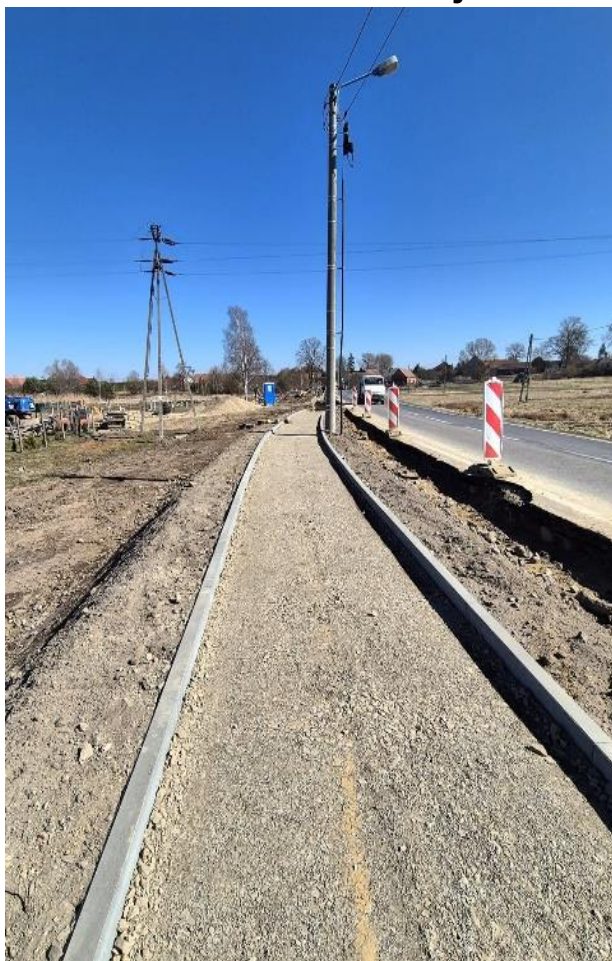
Rysunek 65 Budowa chodnika w miejscowości Parchów
