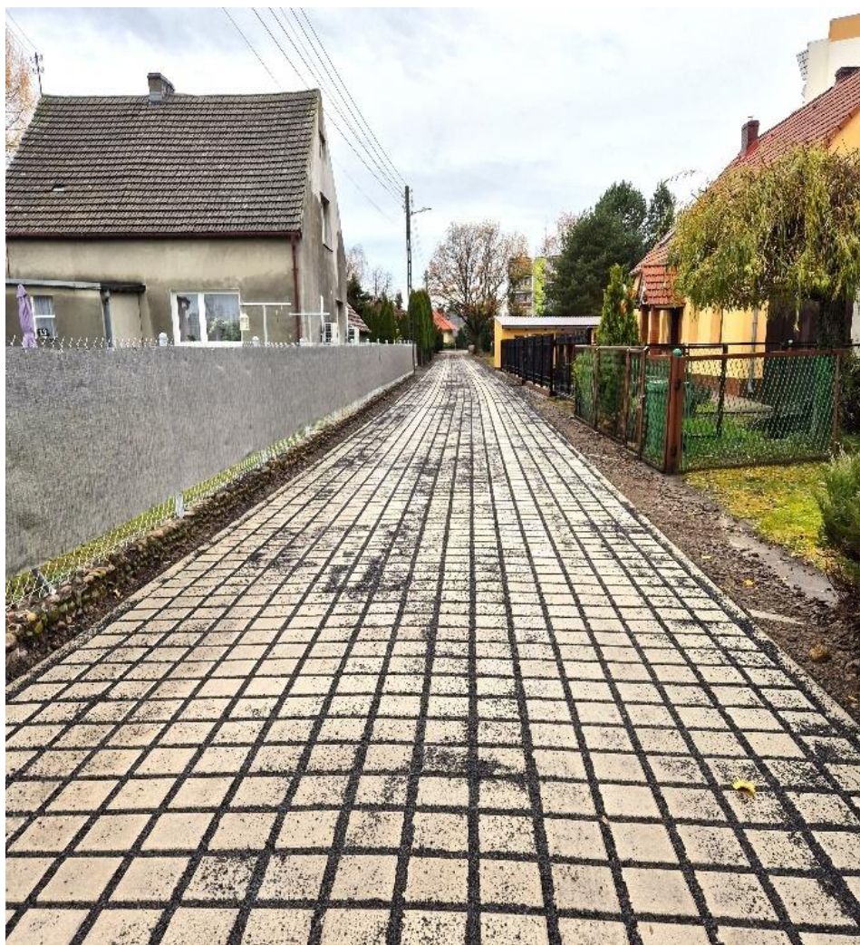
Rysunek 24 Budowa nawierzchni ulicy Sportowej w Chocianowie
