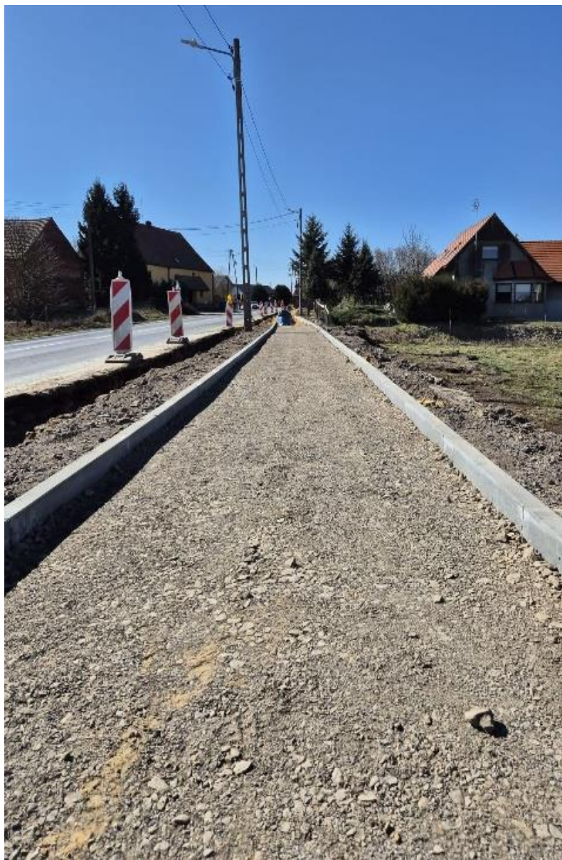
Rysunek 63 Budowa chodnika w miejscowości Parchów
