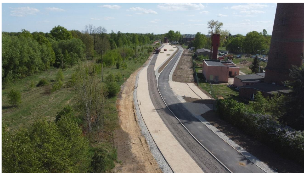
Rysunek 21 Budowa drogi gminnej od ul. Kolejowej do ul. Głogowskiej w Chocianowie
