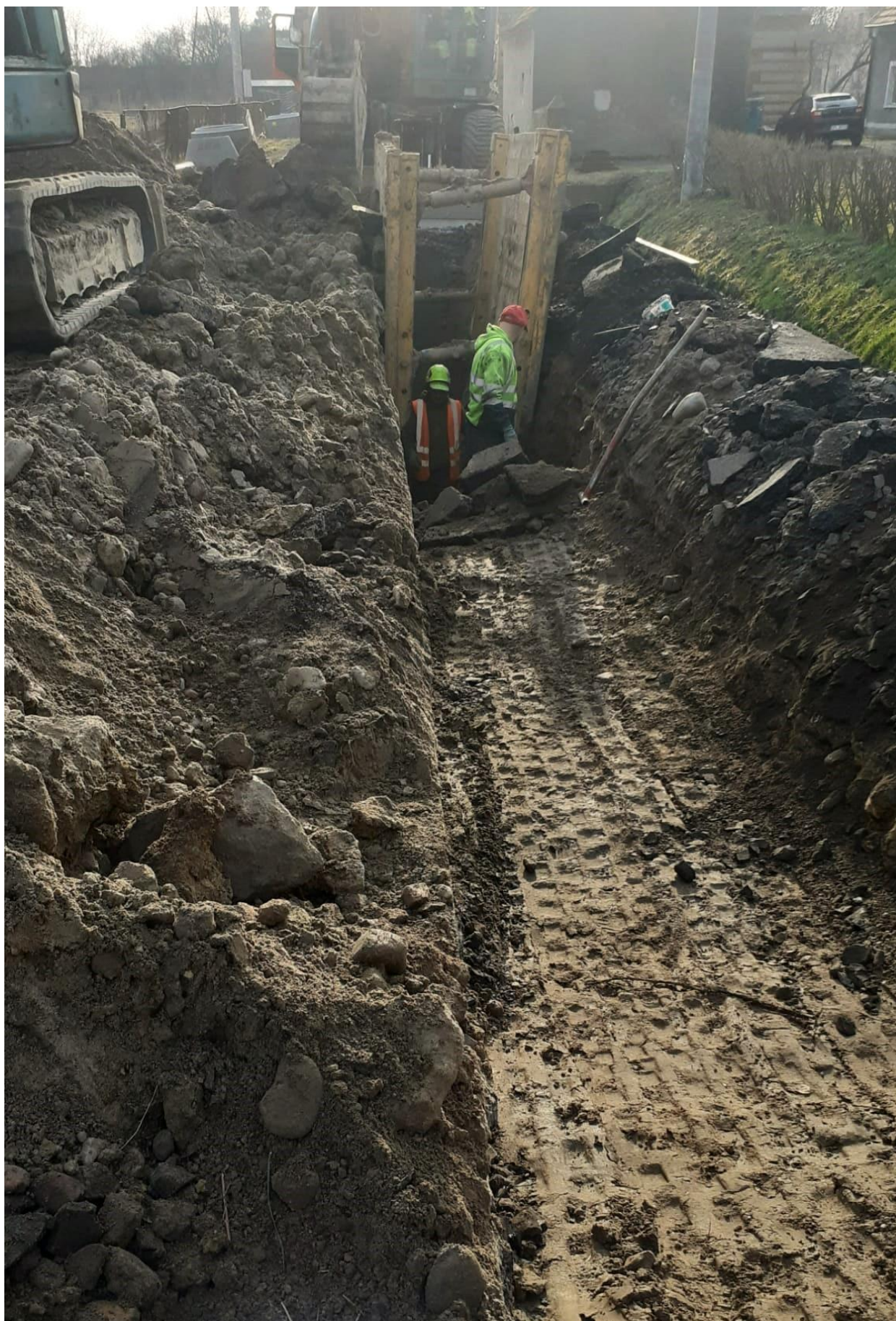
Rysunek 34 Budowa sieci kanalizacji sanitarnej w Gminie Chocianów
