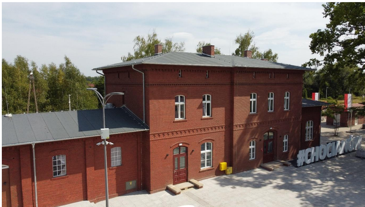
Rysunek 35 Budynek dworca kolejowego w Chocianowie
