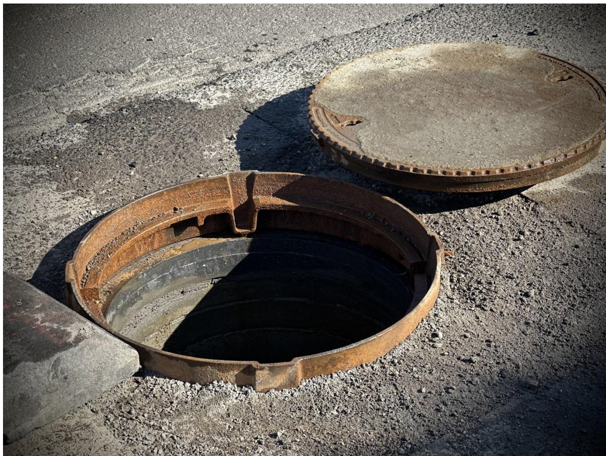
Rysunek 30 Budowa sieci kanalizacji sanitarnej w Gminie Chocianów
