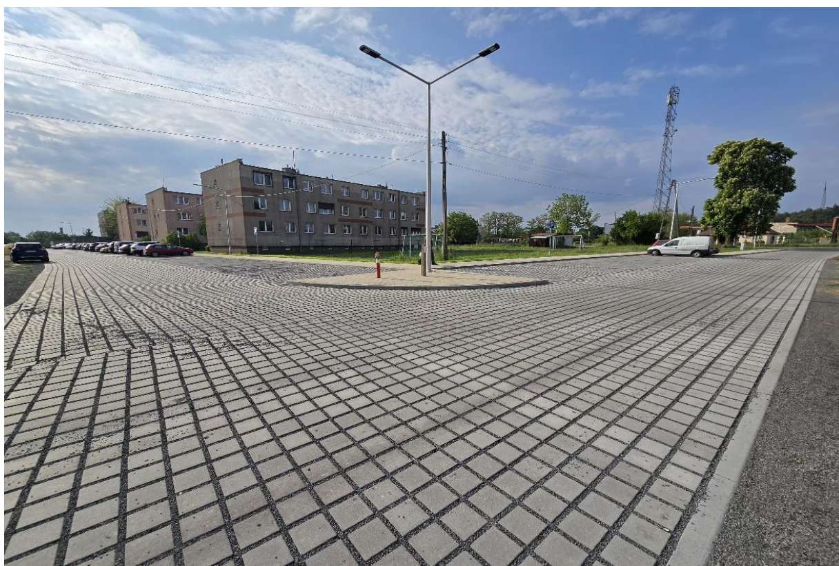
Rysunek 27 Nawierzchnia drogi gminnej w miejscowości Trzebnice
