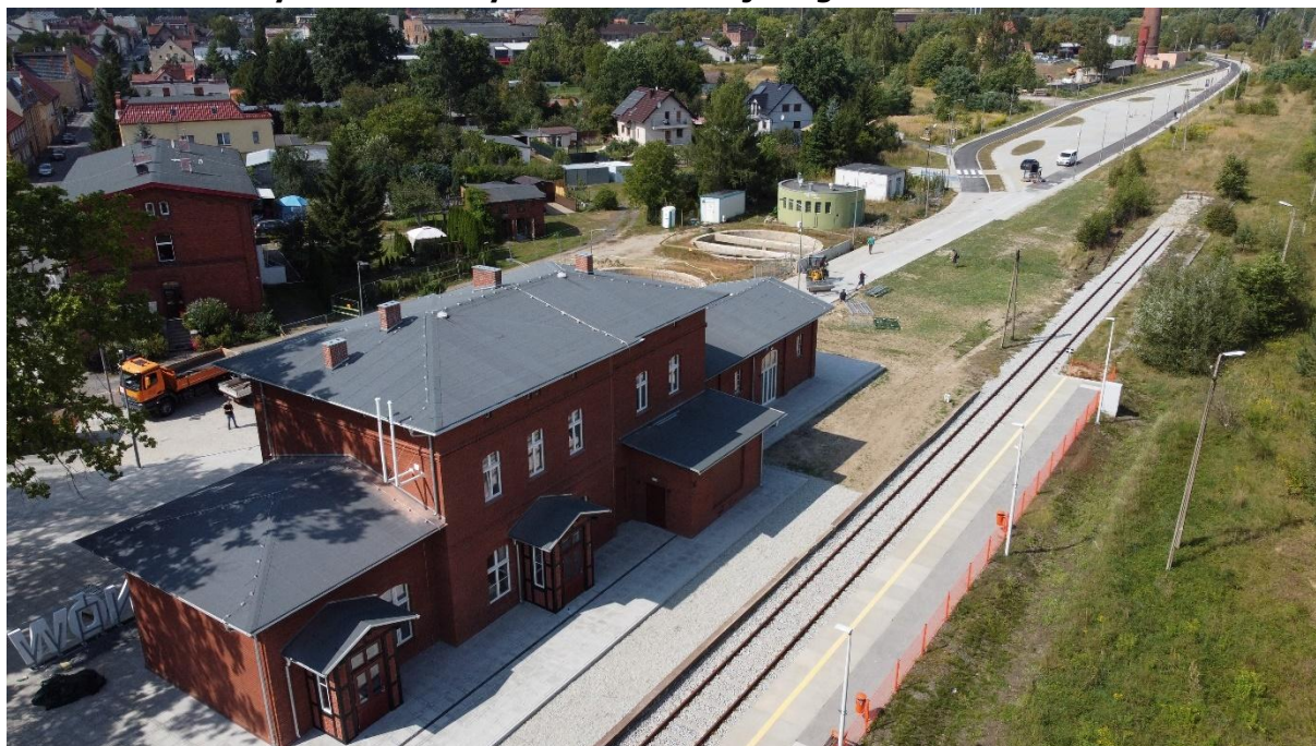
Rysunek 36 Budynek dworca kolejowego w Chocianowie
