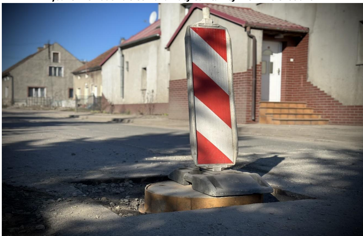
Rysunek 29 Budowa sieci kanalizacji sanitarnej w Gminie Chocianów
