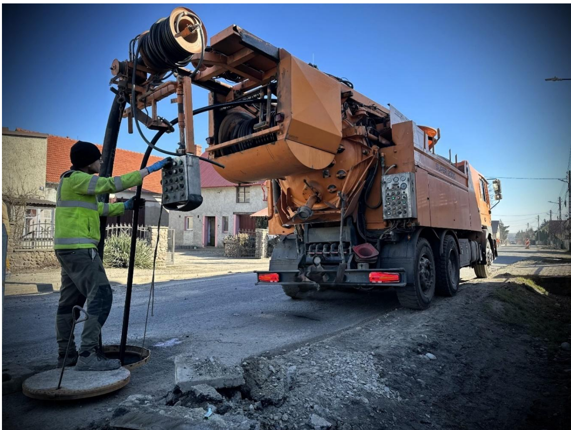
Rysunek 28 Budowa sieci kanalizacji sanitarnej w Gminie Chocianów
