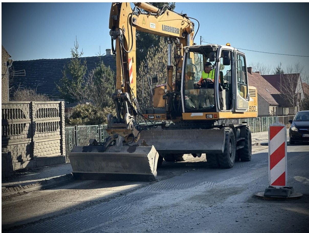
Rysunek 32 Budowa sieci kanalizacji sanitarnej w Gminie Chocianów
