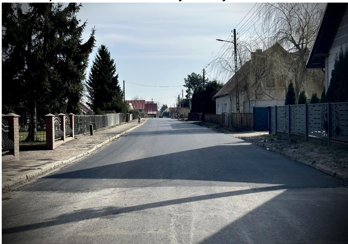
Rysunek 33 Budowa sieci kanalizacji sanitarnej w Gminie Chocianów
