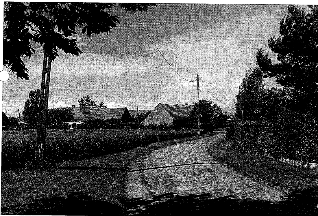
Droga wewnętrzna prowadząca do drogi głównej w Trzebnicach
