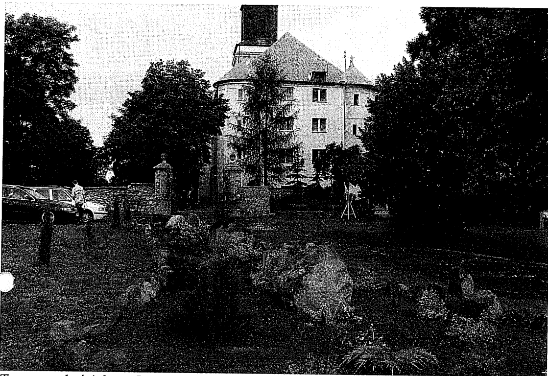
Teren przykościelny – I etap prac związanych z zagospodarowaniem przestrzeni
