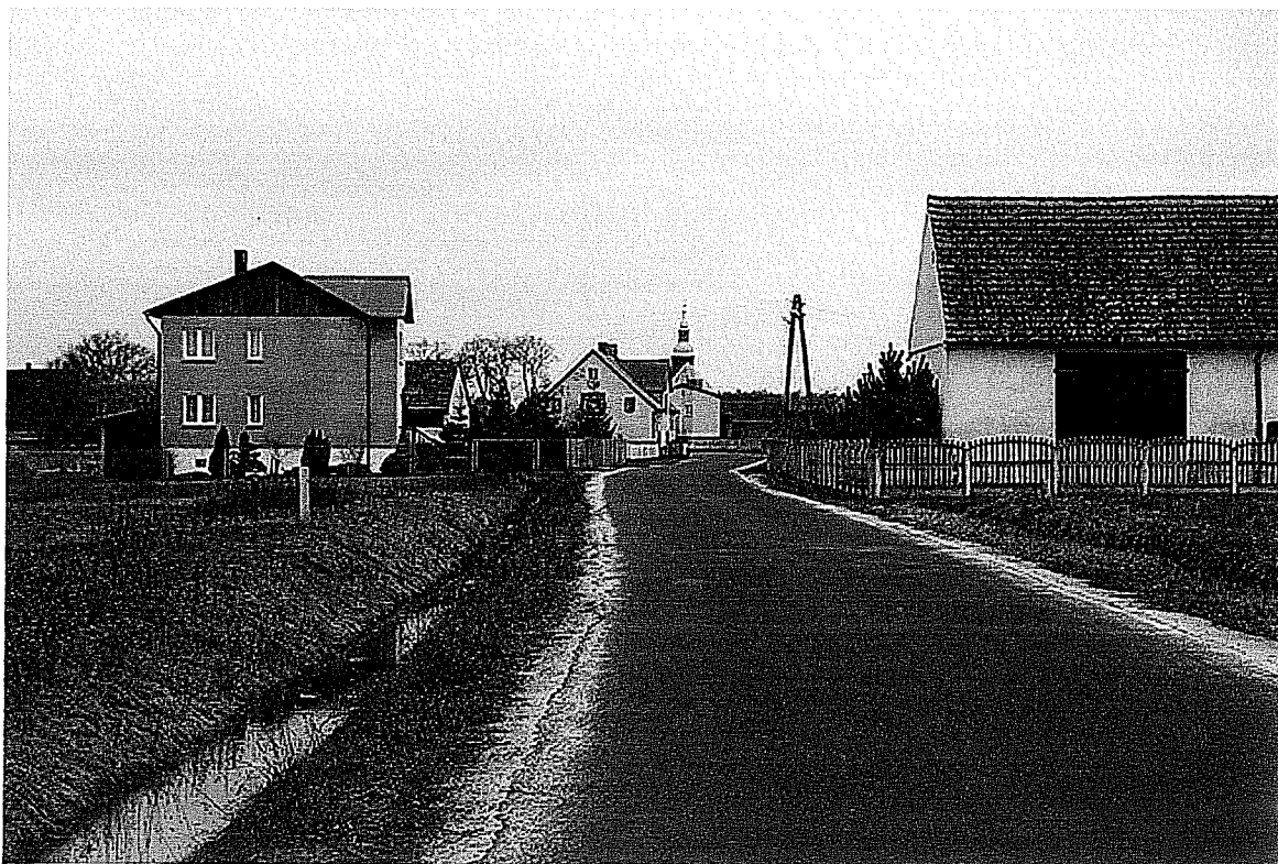
Droga główna przez wieś od strony Parchowa
